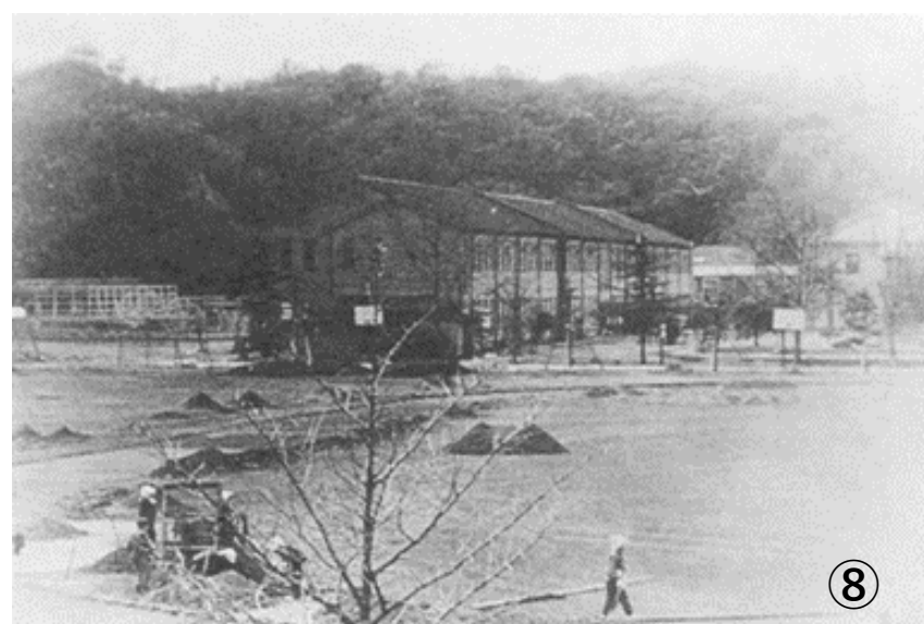
被害を受ける前の校舎の様子
