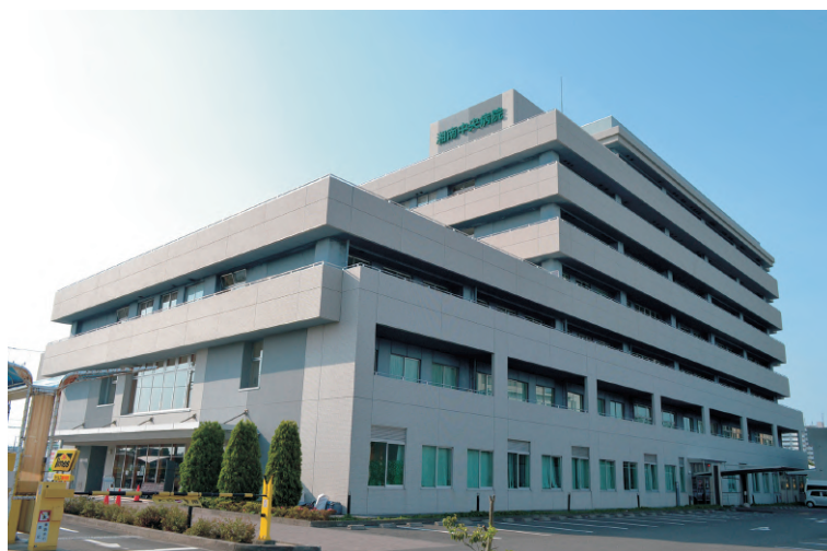
湘南中央病院外観
