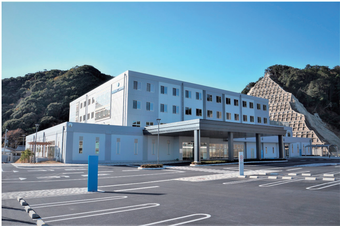
病院施設外観
