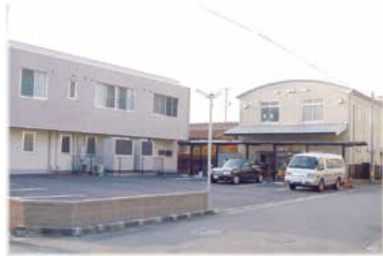
病院東隣にある更衣室棟にある研修医室
