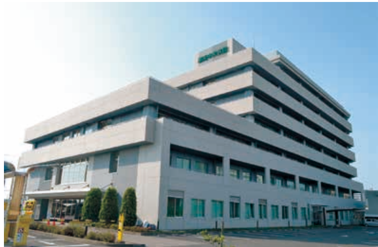
湘南中央病院外観
